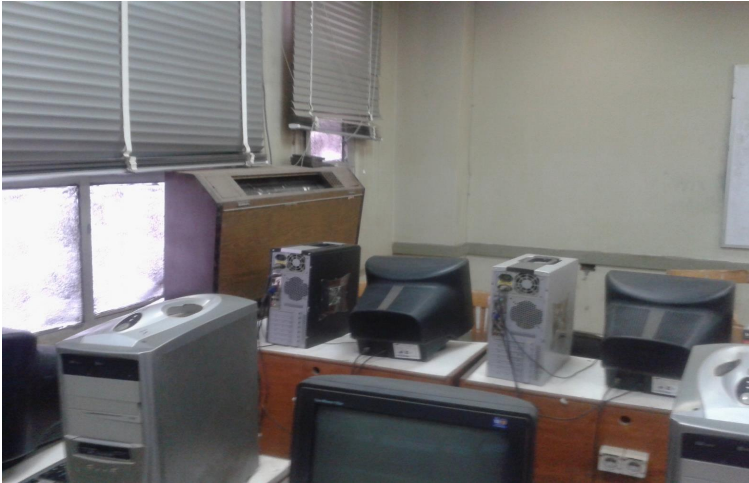
٨- صورة اخرى توضح التكييف الموجود بالمعمل
